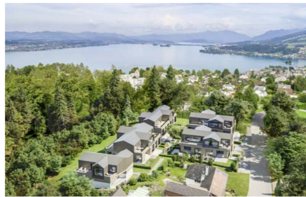
Beim Neubauprojekt Schlosshof werden ein Lastmanagementtool verbaut und mithilfe von Leerrohren die Parkplätze erschlossen, damit ist ein problemloses Nachrüsten der einzelnen Ladestationsanschlüsse für alle Besitzer der Wohneinheiten möglich.
