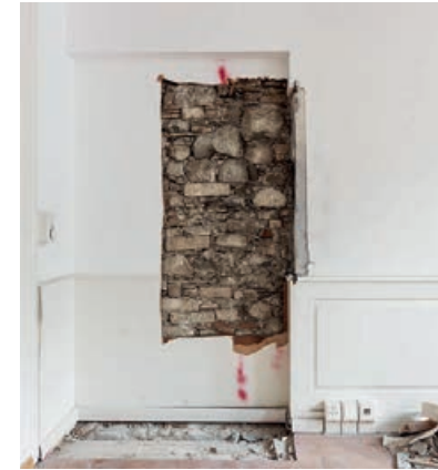
Bestandesaufnahme: Ein Blick hinter die Verkleidungen legt die mittelalterliche Bausubstanz frei.
