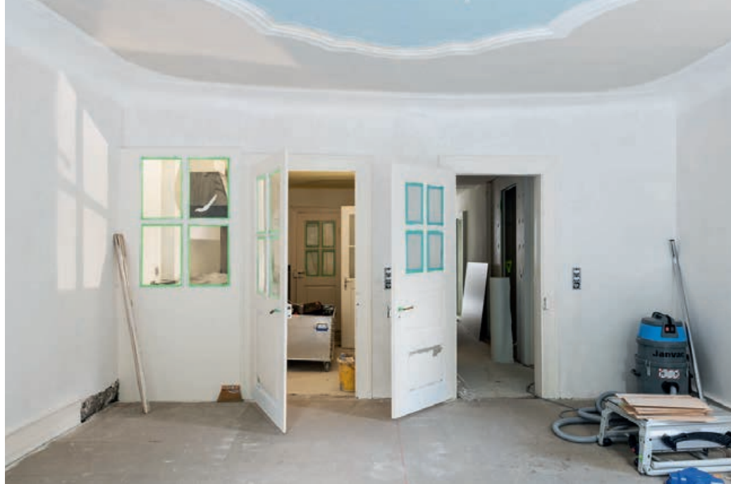
Highlight: Bestehende Stuckaturen wurden restauriert und werden durch die Farbe sogar noch hervorgehoben.
