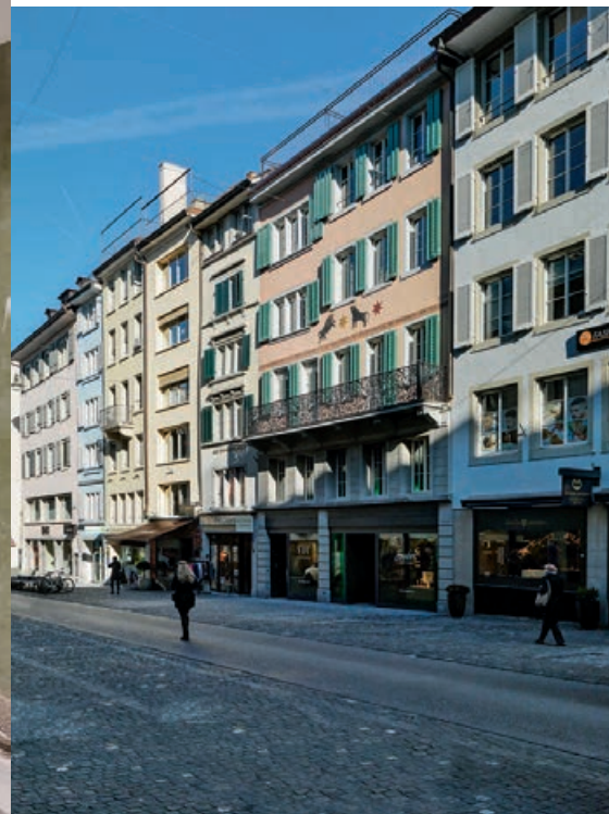
Selbstverständlich: Die Fassade wurde nur sanft saniert und fügt sich wie eh und je in die historische Gebäudezeile des Rennwegs ein.
