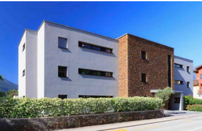
Hermitage | Ascona TI 47 Wohnung / Apartment / Appartamento ca. 115 m² | CHF 1.2 Mio.
